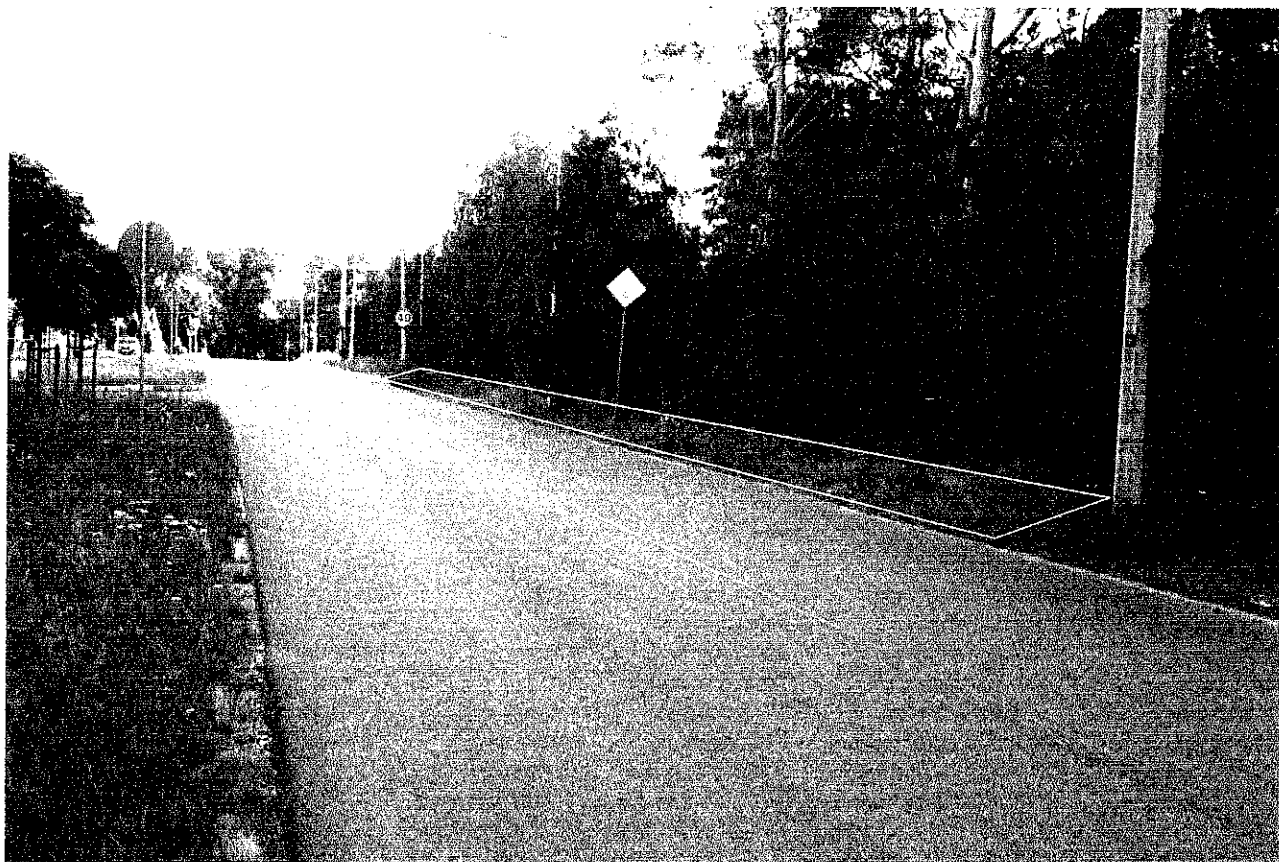
Ul. Zdrojowa; widok w kierunku północno-zachodnim; (żółtą linią wskazano obszar do nasadzeń)
